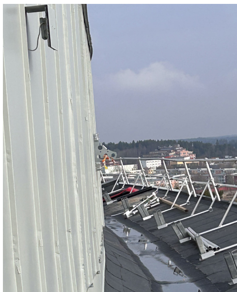
Fallskydd på taket
